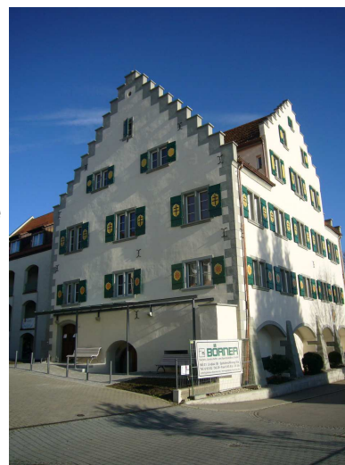
Waldseer Hof nach der Sanierung
