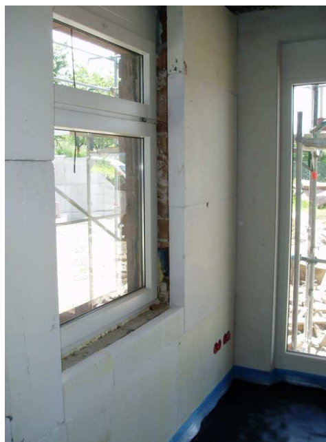
Innendämmung mit epatherm®
