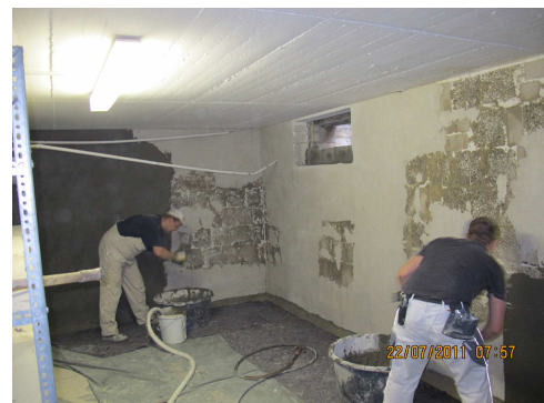
Verarbeiter der Rödiger GmbH dichten die Kellerräume ab mit dem epasit- Sanierputzsystem.
