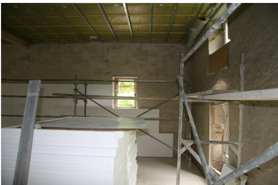
Bild 6: Die Innendämmung mit *epatherm* schreitet voran, die Platten werden im Haus gelagert.
