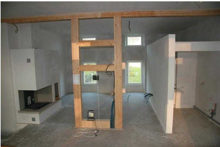
Bild 9: Rechts wird das Bad abgeteilt. In der zweiten Reihe von unten werden dort Heizplatten verlegt, die Anschlüsse für Strom und Thermostat ragen aus der Wand.
