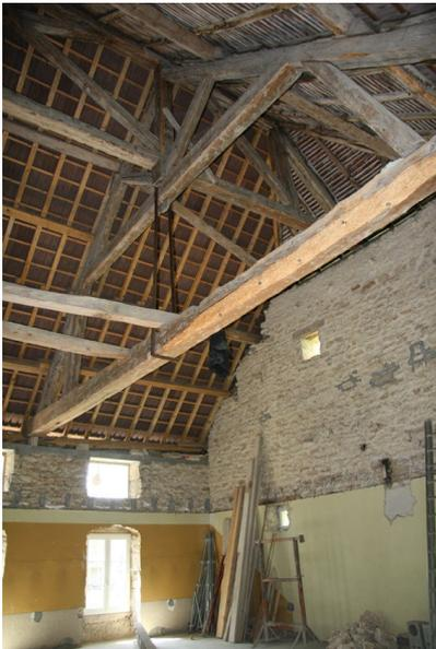
Bild 4 (links): Neue Tragbalken werden eingezogen.
