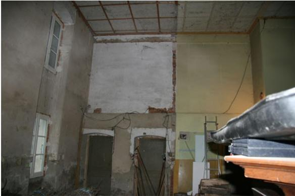
Bild 2: Altputze werden entfernt, neue Fenster und Türen eingebaut.
