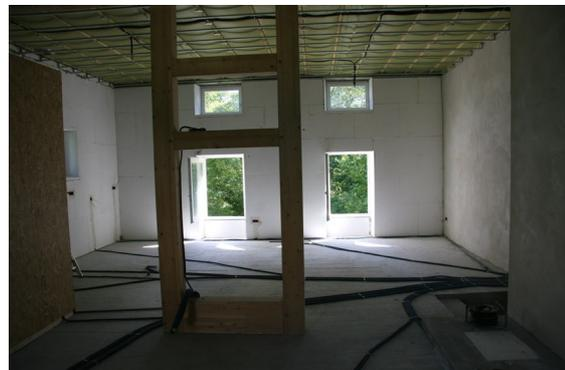
Bild 7: Die rechte Wand ist mit Putz ausgeglichen, die übrigen Wände bereits mit Wohnklimaplatzen versehen.
