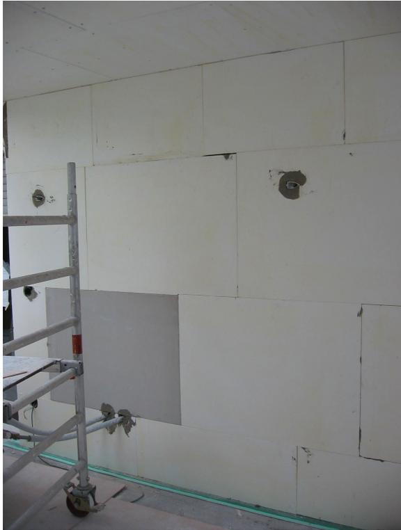
Bild 11: Mit einer beheizbaren Innendämmung lässt sich die teure nachträgliche Installation einer Heizung vermeiden.
