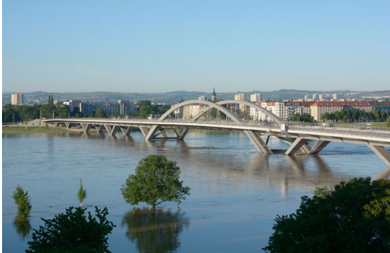
Bild 2: Das Elbehochwasser unterspülte auch die im Bau befindliche Waldschlößchenbrücke in Dresden.
