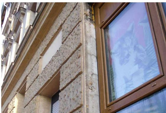
Bild 1: Neue Fenster, Leibung vor der Sanierung.
