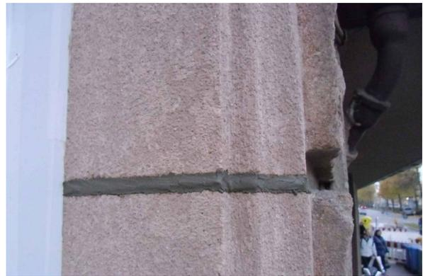
Bild 8: Die Fugen wurden aufgefüllt mit Fugensaniermörtel *epasit fsm*.
