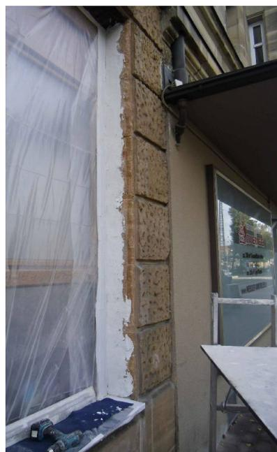
Bild 2: Lose Bestandteile wurden entfernt und das Gestein mit Sandsteinverfestiger epasit sv getränkt.
