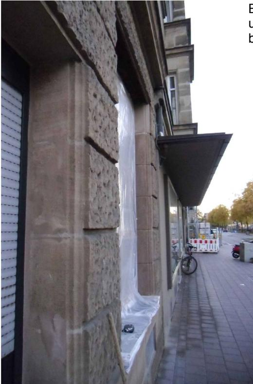
Bild 7: Die Oberfläche wurde mit unterschiedlich starkem Schleifpapier behandelt.
