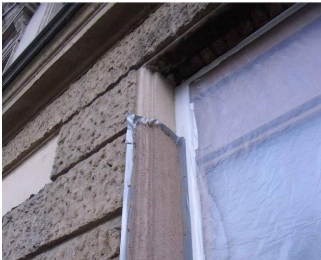
Bild 5: Sandsteinsaniermörtel wird farblich passend angemischt und aufgetragen.
