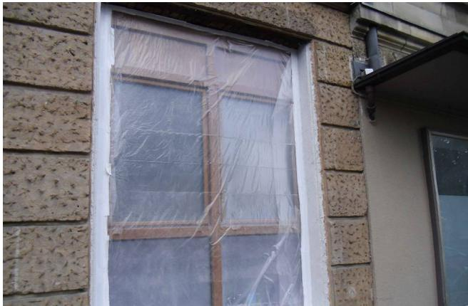
Bild 4: Zugkern aus Renoviermörtel epasit 5in1 erstellt.
