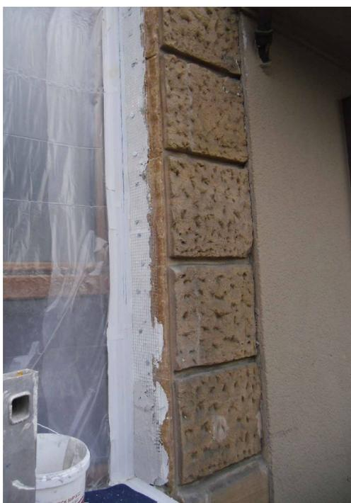
Bild 3: Anbringen einer Metallarmierung zur Verbesserung des mechanischen Halts.
