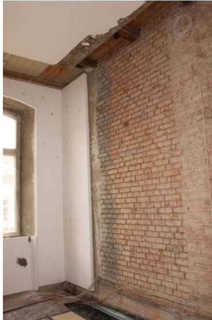
Bild 4: Ab einer Wandhöhe von 2,80 m werden die Platten geklebt und zusätzlich verübelt
