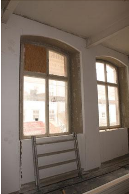
Bild 3: Rund um die dominierenden Rundbogenfenster wird das Mauerwerk mit epatherm-Platten gedämmt
