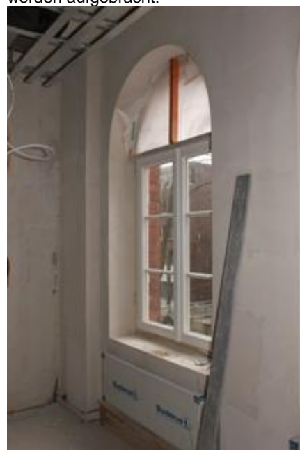
Bild 8: Während der Dämmmaßnahmen.
