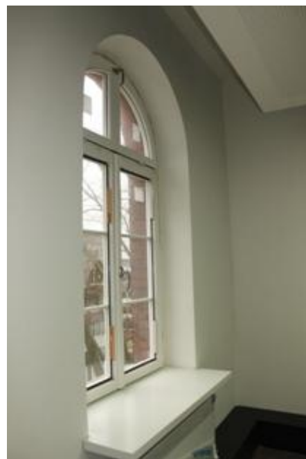
Bild 10: Malerfertig: Die sanierten Wände und Rundbogenfenster.
