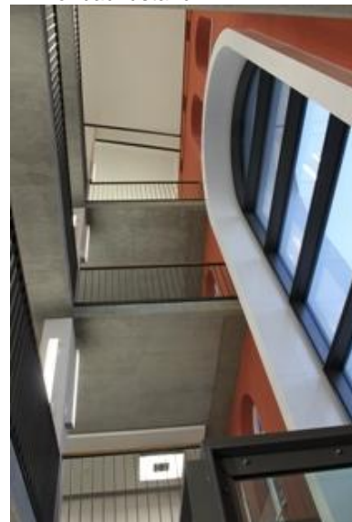
Bild 4: Das sanierte Treppenhaus.
