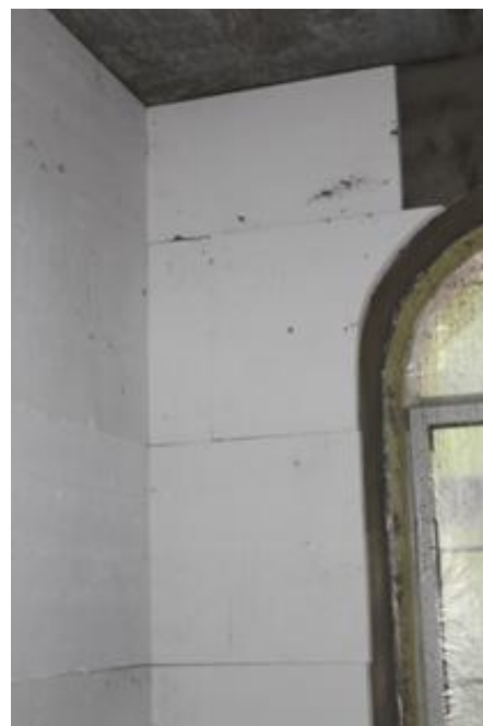
Bild 6: Außenwand mit Rundbogenfenster, epatherm Platten werden aufgebracht.
