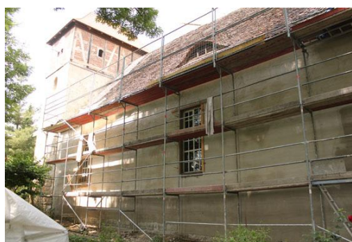
Bild 6: Der neue Putz wird aufgebracht
