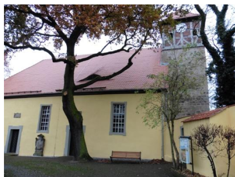
Bild 8: Frisch saniert nach Originalrezeptur
