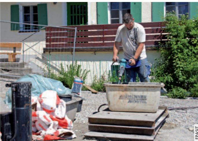
Gleich bereit zur Verarbeitung: Der Epasit Mineral-Dicht sperr wird mit Wasser knollenfrei angerührt.
