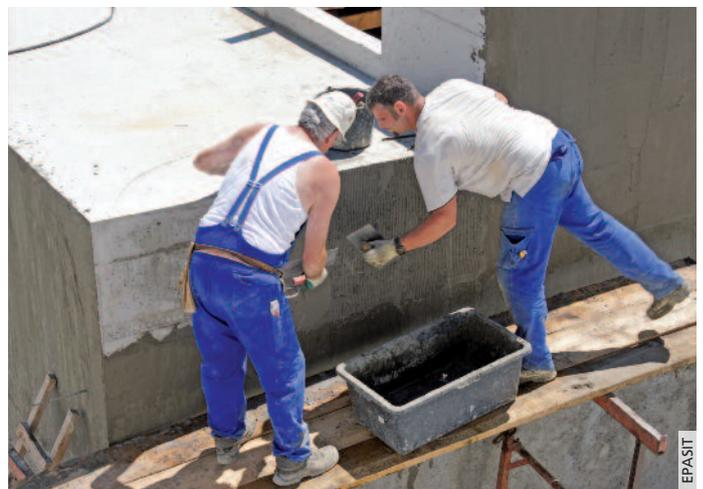
Der Sperrputz wird mit der Traufel auf die Außenwände im erdberührenden Bereich aufgetragen.
