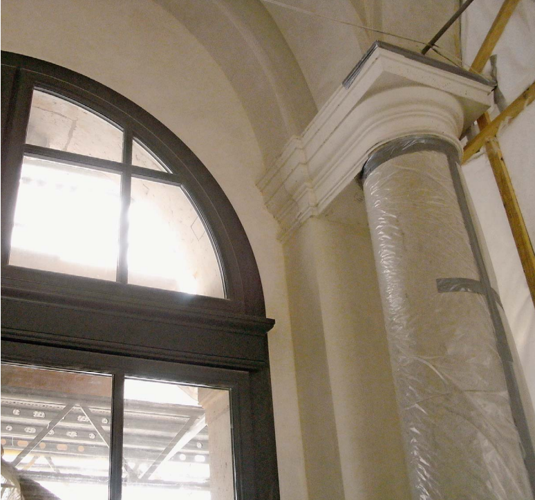
Nach der Sanierung der Bogen und Leibungen.
