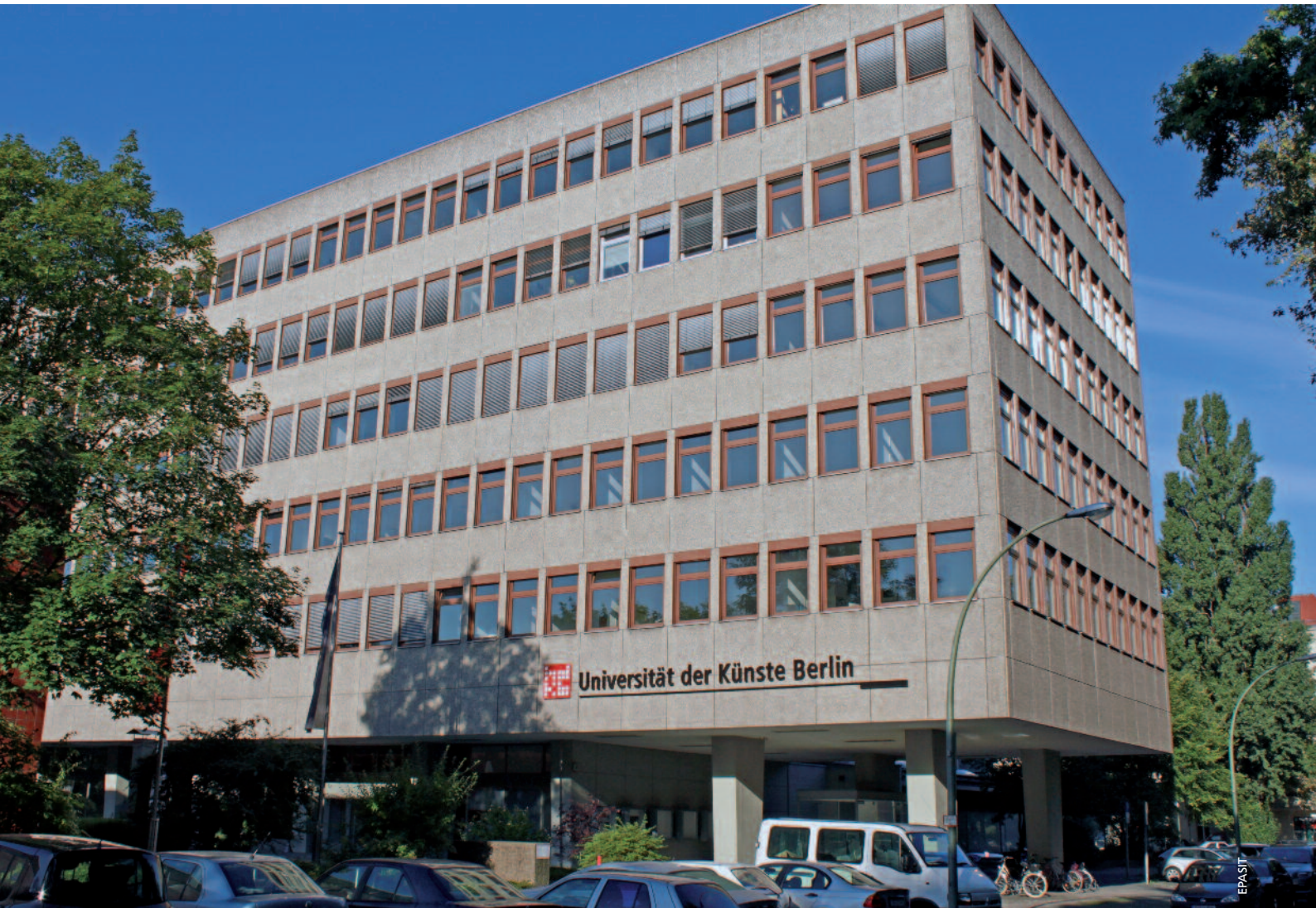
Universität der Künste in Berlin mit denkmalgeschützter Fassade
