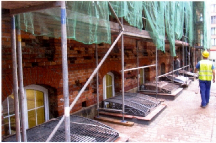
Ziegelrestaurierung an der Universität Krakau
